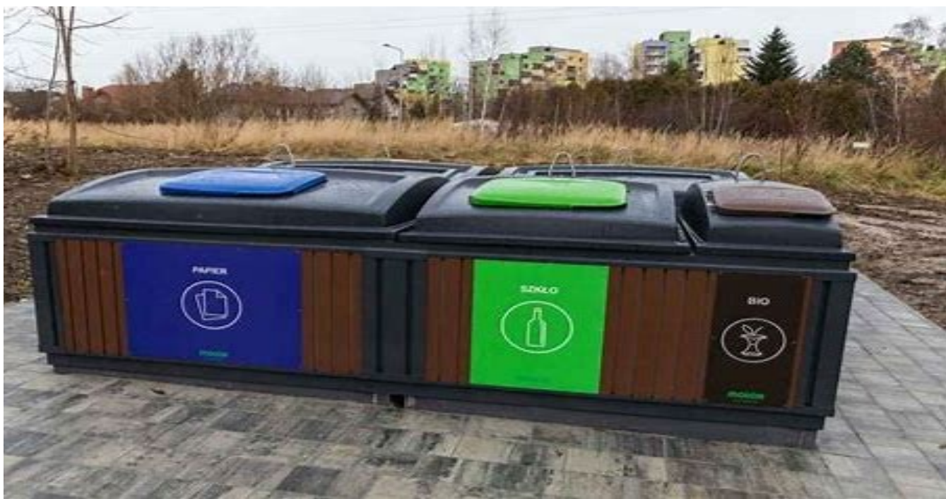
Pojemniki na odpady z wbudowaną główną komorą zbiorczą pod ziemią w Szczecinie. Źródło: https://wiadomosci.szczecin.eu/ [dostęp: 15.12.2024]
